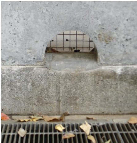
図4 ネズミ防御 のある排水 孔。網目は もう少し細 かいのが良 い。 (外観)
